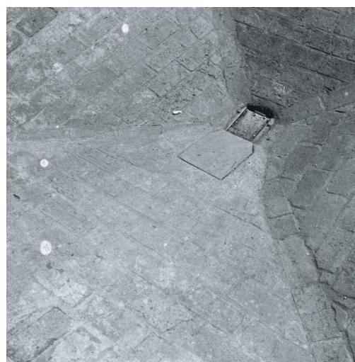
Moega onde é depositado o café da roça que é evacuado através do registro, no fundo, para uma canaleta que transporta o produto para o lavador “Maravilha”. Fazenda Lageado, Botucatu, São Paulo, 17 de junho de 1955.
