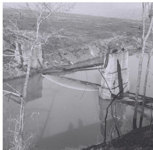
Ponte queimada pelo incêndio rural, entre Mandaguari e Astorga sobre o rio Pirapó. Paraná, 29 de agosto de 1963.
